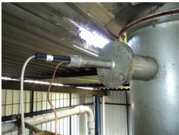
Foto 04: Coluna Cromatográfica-Sonda
