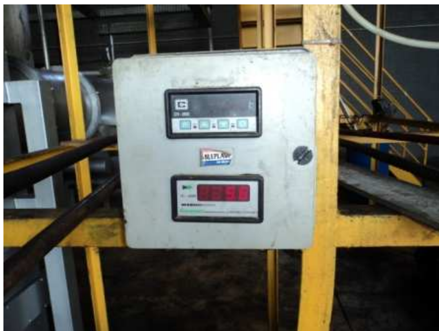
Foto 01- Painele de Controle das Temperaturas do Incinerador UDI Ambiental
